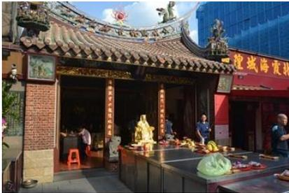
レンガの壁に、床と屋根を木造で載せる。
