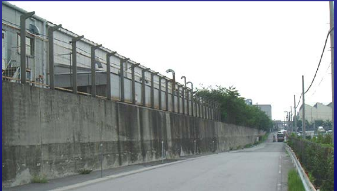
計画地 南側道路の旧状
