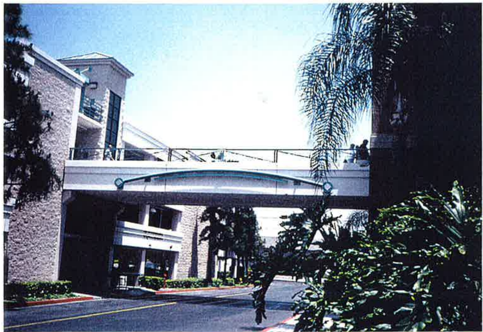
客のメインアプローチはここなのです。 壁面のボリューム。実はブロック積みとはオドロキ。日本では学会と建設省によっ てセメントに色粉が入れられない。
