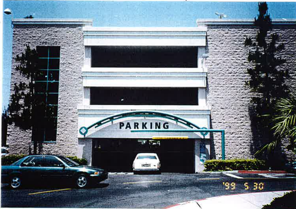
ノードストロームの立体駐車場 組積造か？ コストをかけている
